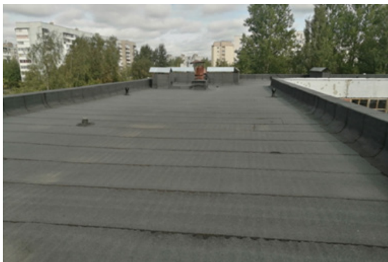
Капитальный ремонт крыши
