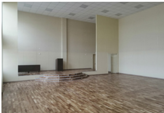
Капитальный ремонт актового зала
